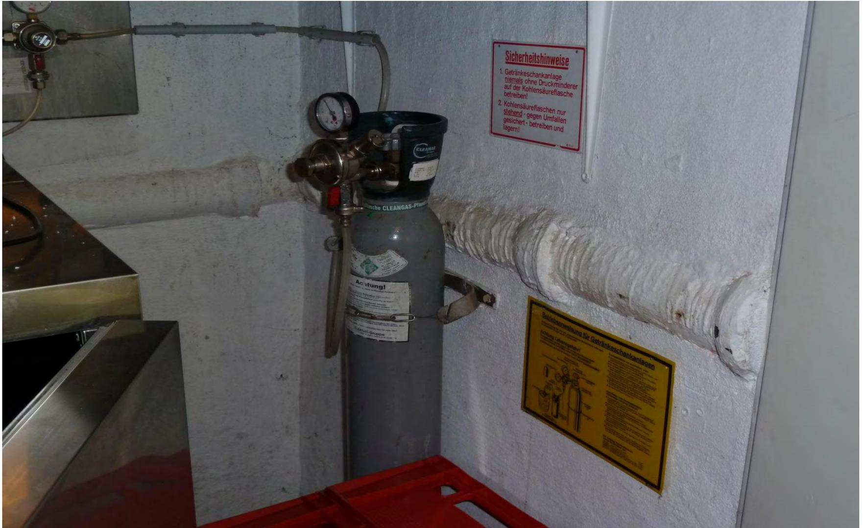
Druckminderer für Bier bis 6 Bar bei etwas 2 Bar Betriebsdruck
